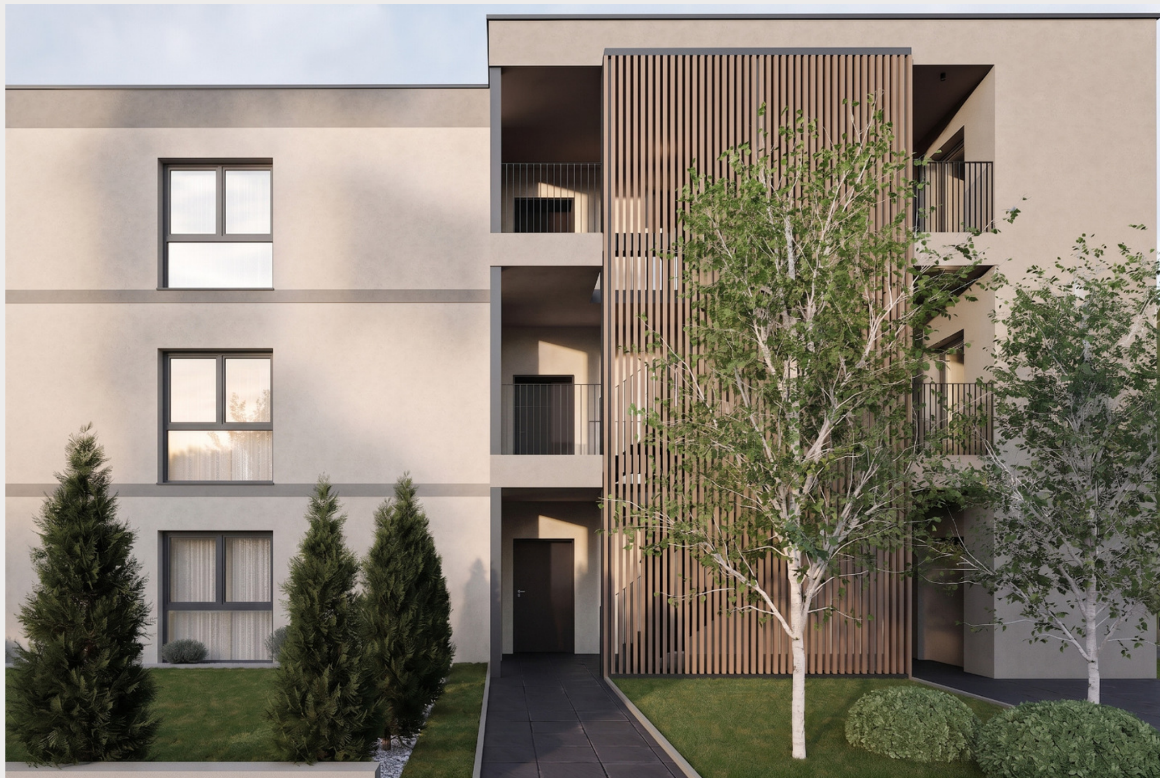
Obermattweg 20 in Buchs - Ansicht Ost
